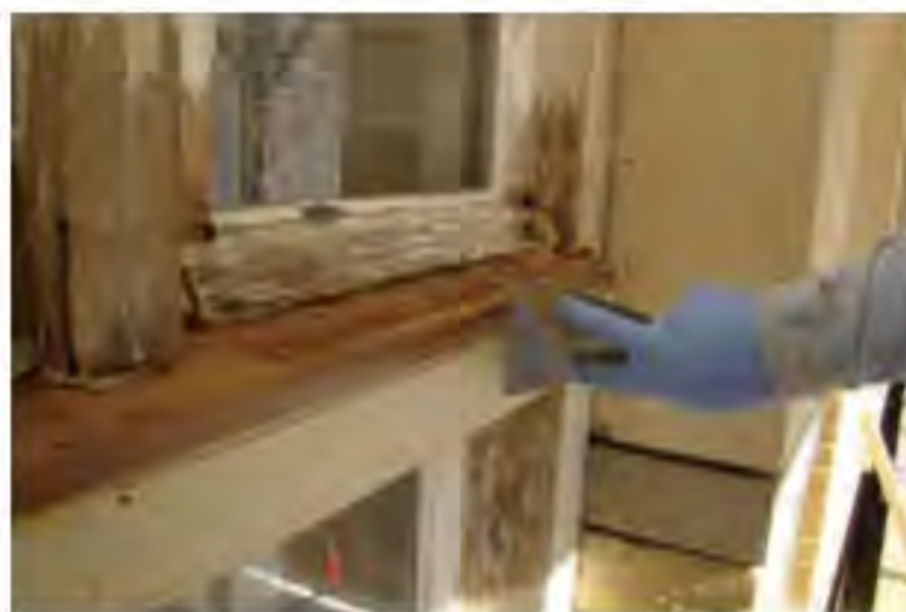
Afmessen na het aanbrengen van Renoflex en het daarin gedrukte nieuwe deel.
